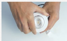
Schroef de buitenflens vast met een kwartdraai Visser la collerette extérieure d'un quart de tour
